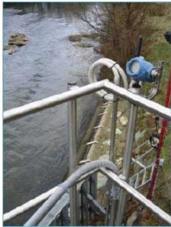
图 5. 醋酸厂通过无线变送器监测排水温度，以满足环境法规。
