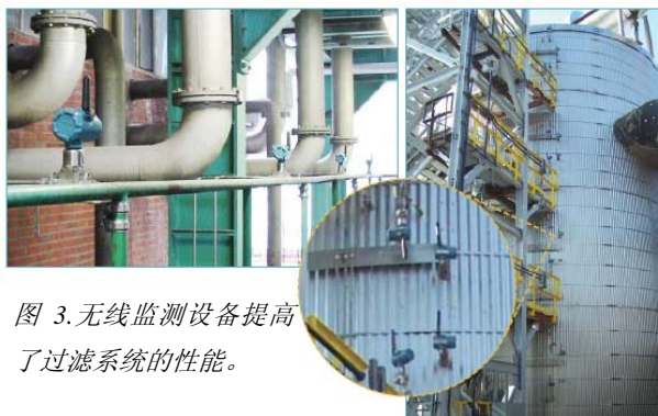
图 4. 自组织无线网络监控化肥厂反应罐上的 16 个测点。
