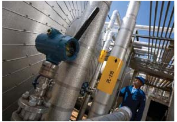
安装于 BP 贮油站的智能无线变送器
